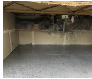
34401 Capitol garage RetroCoat
