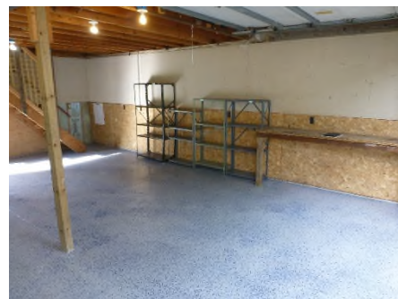
34367 Capitol garage RetroCoat
