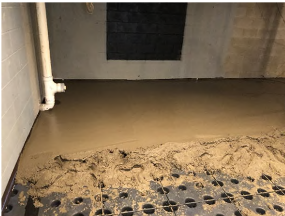
Concrete pour over the Cupolex flooring
